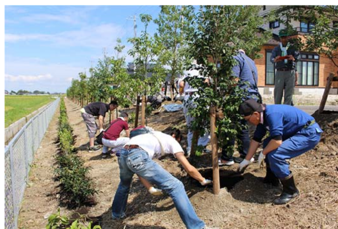
写真：外周緑地の植栽の様子
