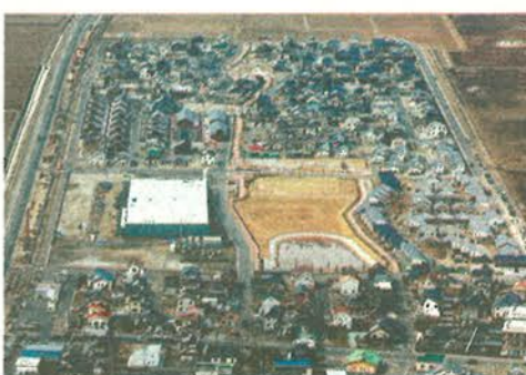
災害公営住宅などが完成し、7月に「まちびらき」を控える玉浦西地区(本社機から)
